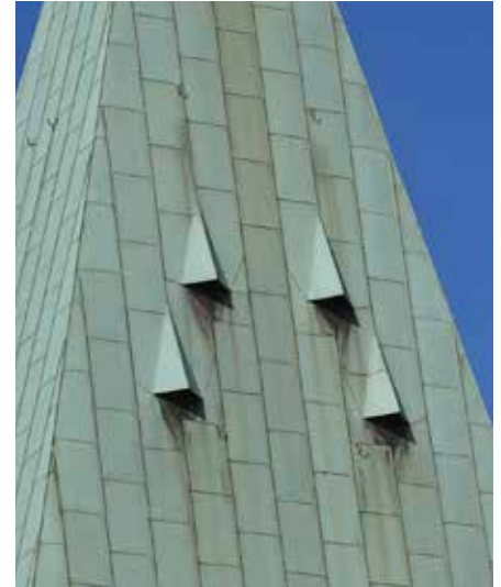
Die „Schalllöcher“ im Glockenturm
